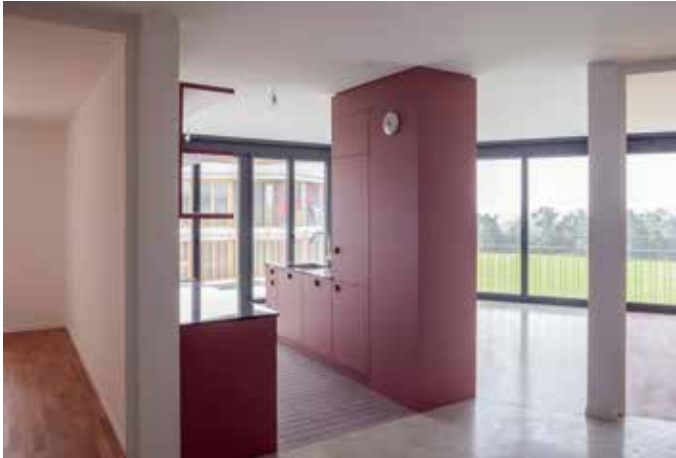
Dans chaque logement, les traitements de sol répondent aux géométries du plan : carrelage et parquet pour les espaces orthogonaux, résine pour les surfaces biaises. (PHOTOGRAPHIES ET PLANS MIS À DISPOSITION PAR LE BUREAU DREIER FRENZEL)
