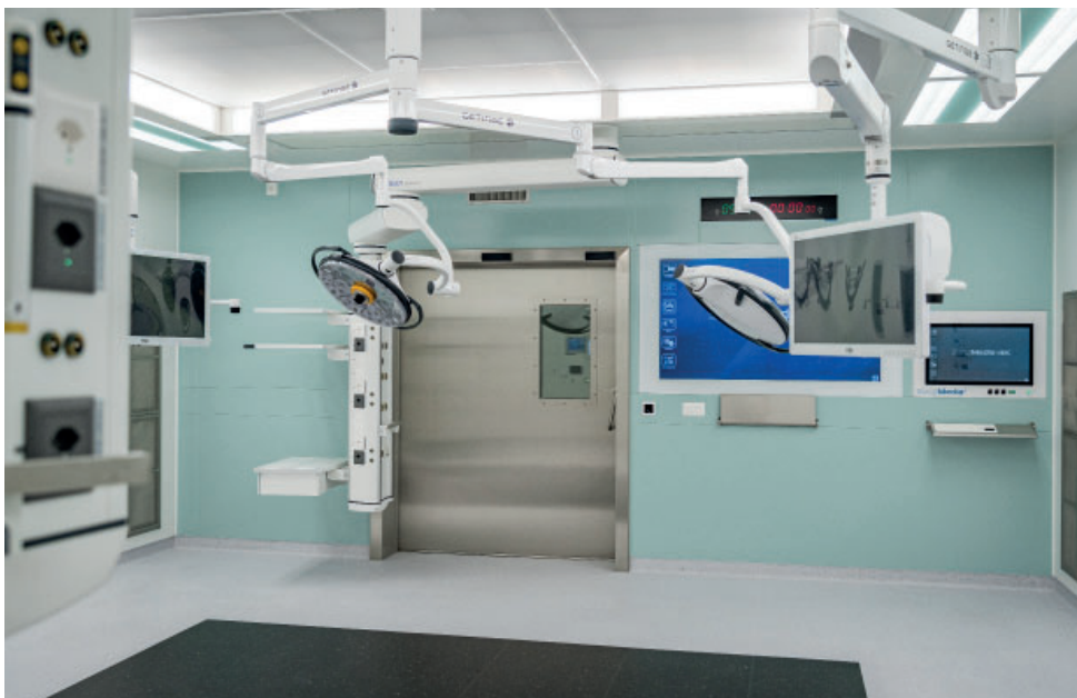
photo: Nicolas Pierret, bloc opératoire central
